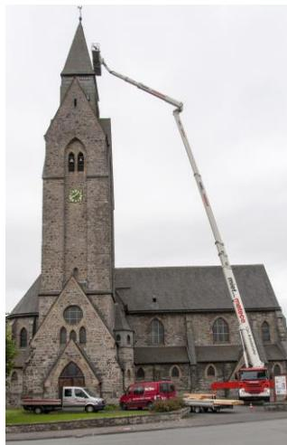
Die Firma Balkenhol-Bedachungen hat im Juni 2018 die Eindeckung repariert. Dazu musste ein 72 m – Spezialkran aus dem Ruhrgebiet anrücken.
