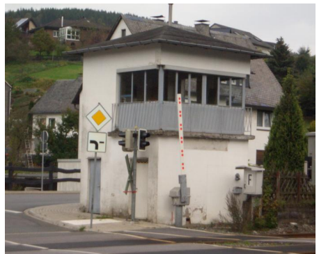
Das Stellwerk am Dümel kurz vor dem Abriss
